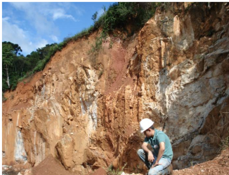
FIGURA 16 - Relevo acidentado com declividade superior a 30%, em uma das pedreiras localizadas na sub-bacia do Rio Bacaetava, município de Colombo - PR. Observar à esquerda a vertente coberta por vegetação.
