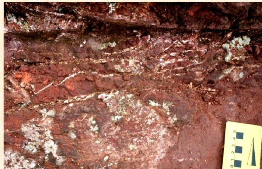
Grupo Castro – Castro (PR). Zona de cisalhamento rúptil (em planta) gerada por falha transcorrente. (Foto: E. Salamuni)
