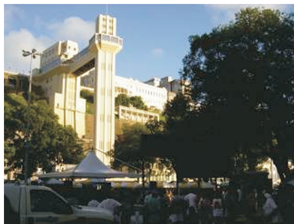
Figura 20 – Elevador Lacerda que liga os blocos alto e baixo da falha.
